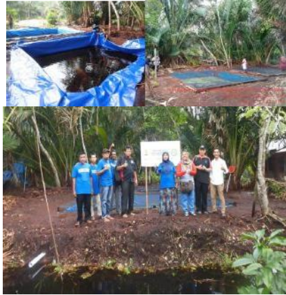
Gambar 2. Proses pembangunan kolam
